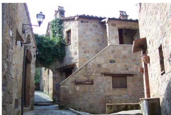
Alcuni esempi di degrado dovuto ad interventi inappropriati sono le molteplici tettoie realizzate in ferro e pannelli di materiale plastico o eternit, i discendenti in plastica, avvolgibili e infissi in alluminio.
