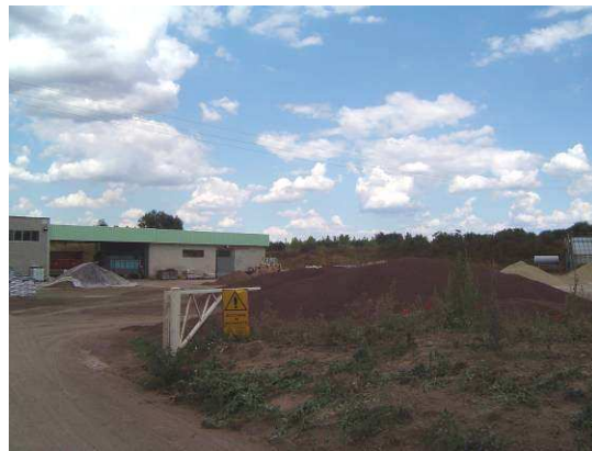
Impianto di produzione terricci
